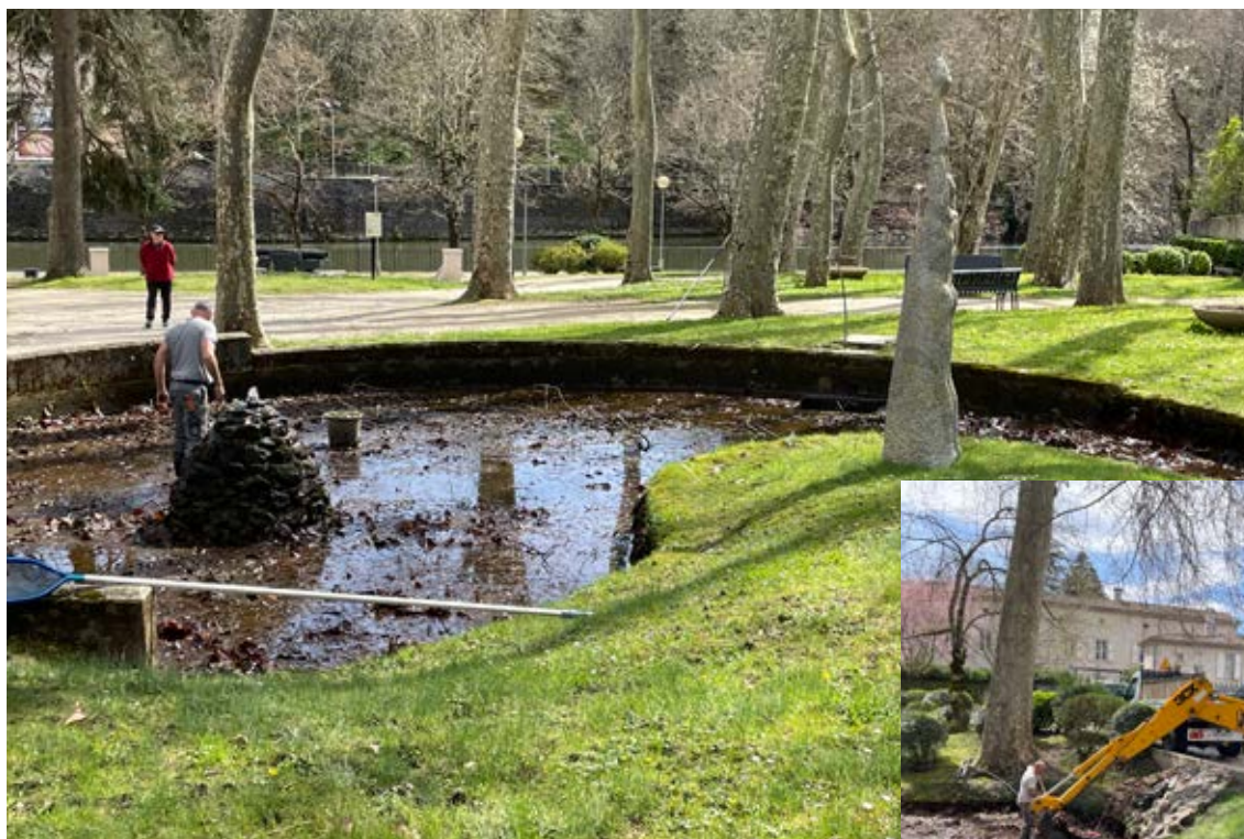
Nettoyage du bassin
