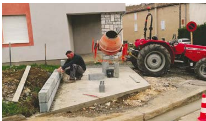
Réparation de la murette du pont
