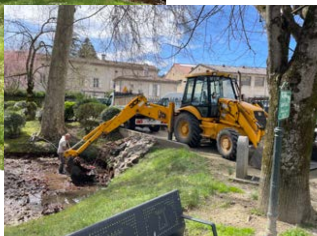
Nettoyage du bassin
