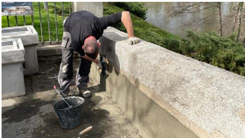
Réparation de la murette du pont
